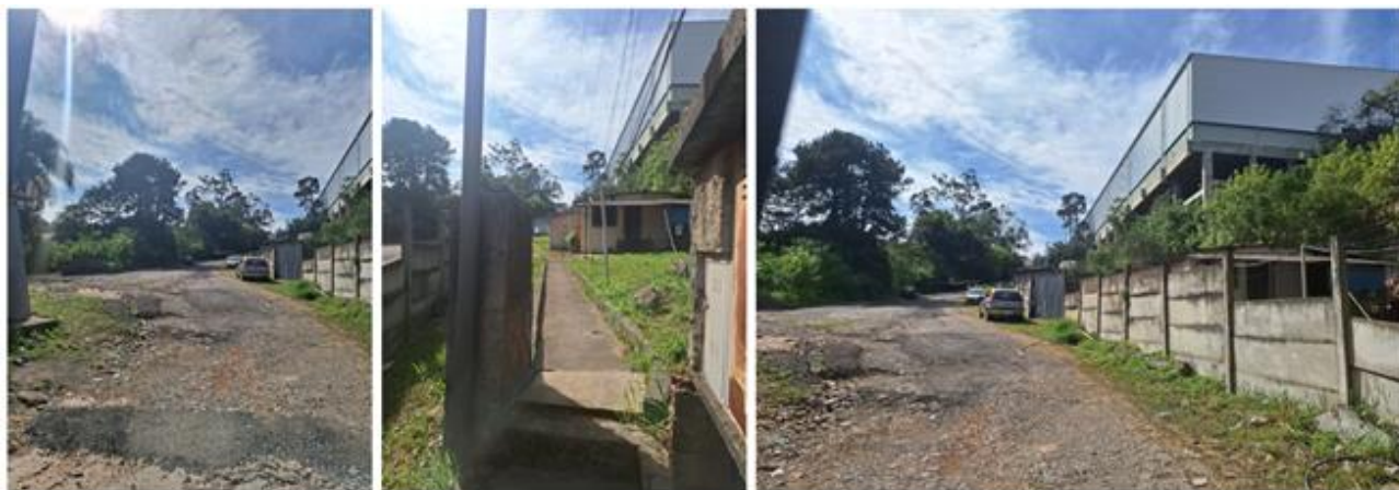
Terreno Três Montanhas em maio de 2025 (Visita realizada por técnicos da PMO)
