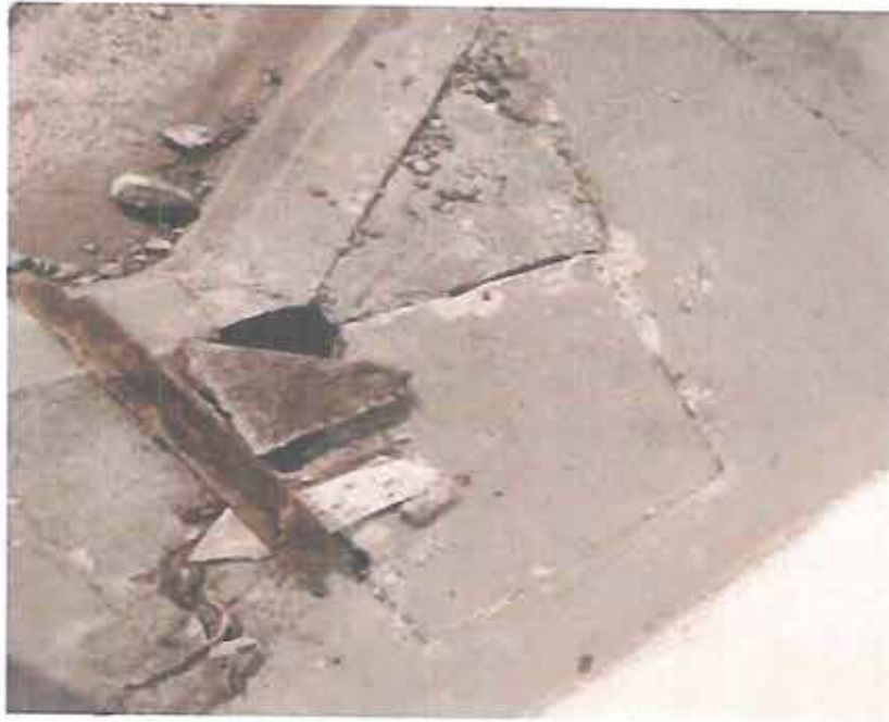
Pintura do piso da entrada da upa
