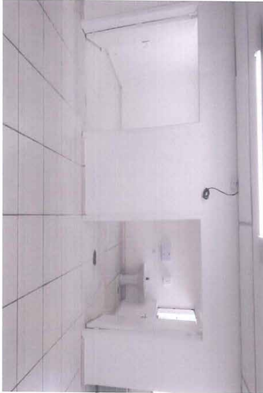
Sala de triagem reformada
